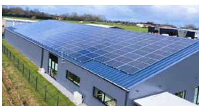
Vos toitures photovoltaïques pour générer une nouvelle source de revenu.
