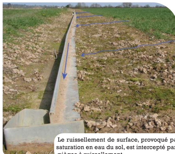
Le débit est mesuré par des bacs déversoirs.
