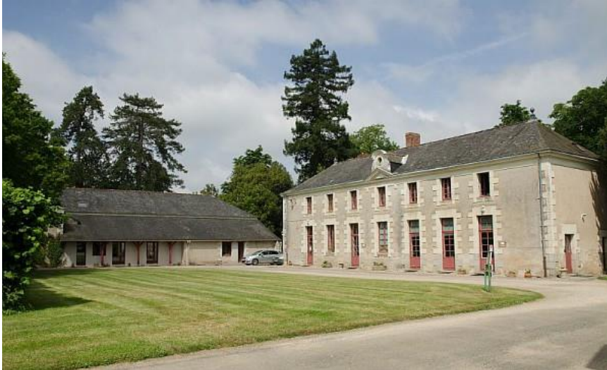
Bâtiment principal de la station expérimentale de La Jaillière – Crédit ARVALIS, N. Cornec
